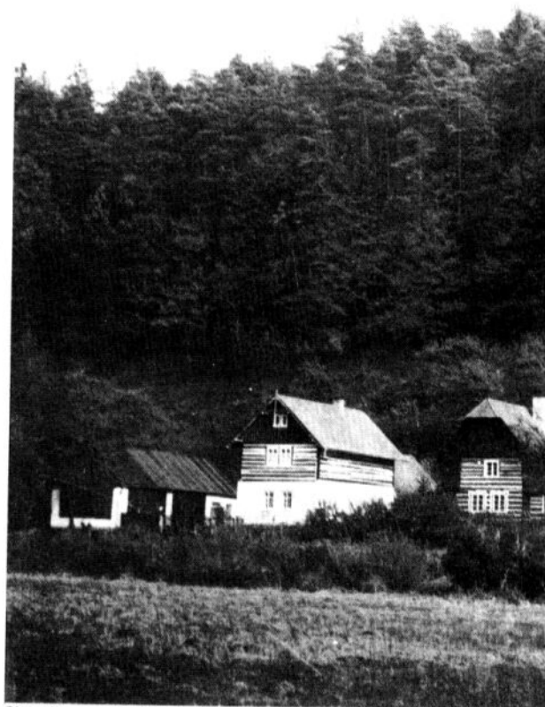
Charakteristické lidové stavby ve SPR Kokořínský důl
