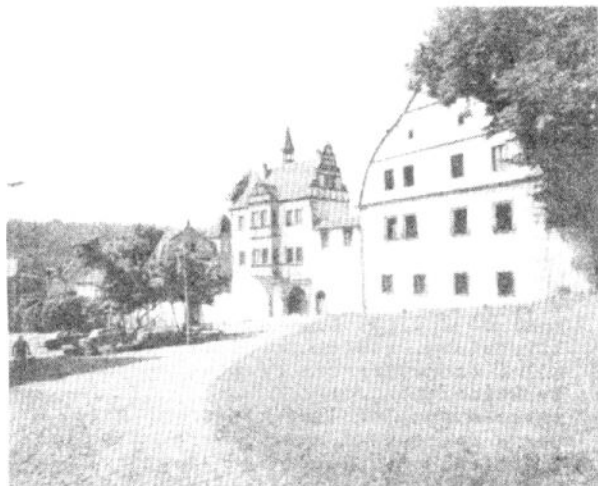
Zámek v Benešově nad Ploučnicí
