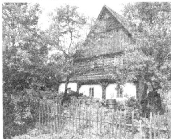
Lidová architektura v obci Srdoč
