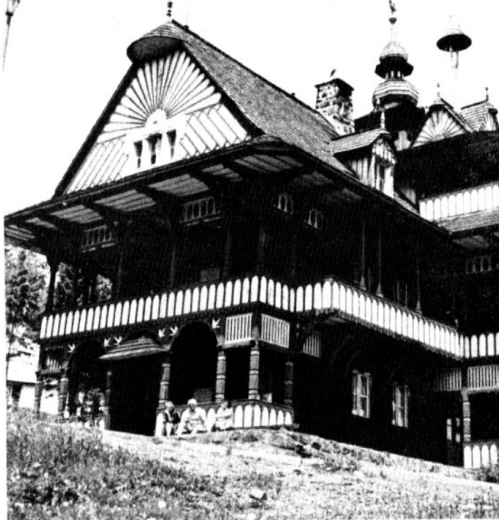
Areal Jurkovičových staveb na Pustevnách, chráněná památka
