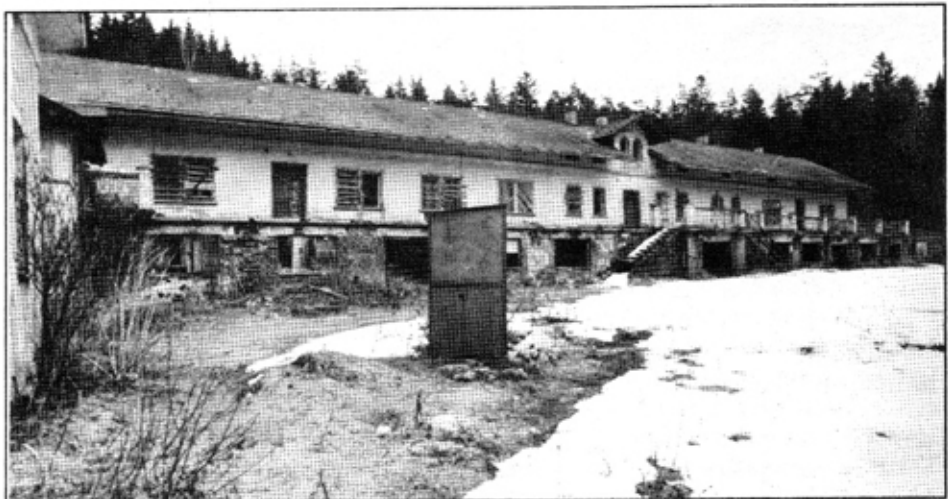
Stav budovy lázní Kyselka v Louce v dubnu 1983. V popředí kryt vrtu, kde se nyní stáčí MAGNESIA
