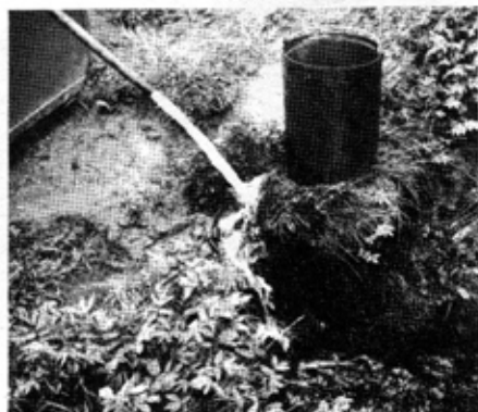
Vývod jednoho z vrtů v Kyselce u Louky, jehož minerální voda zaplavuje nebo eroduje okolní terén
