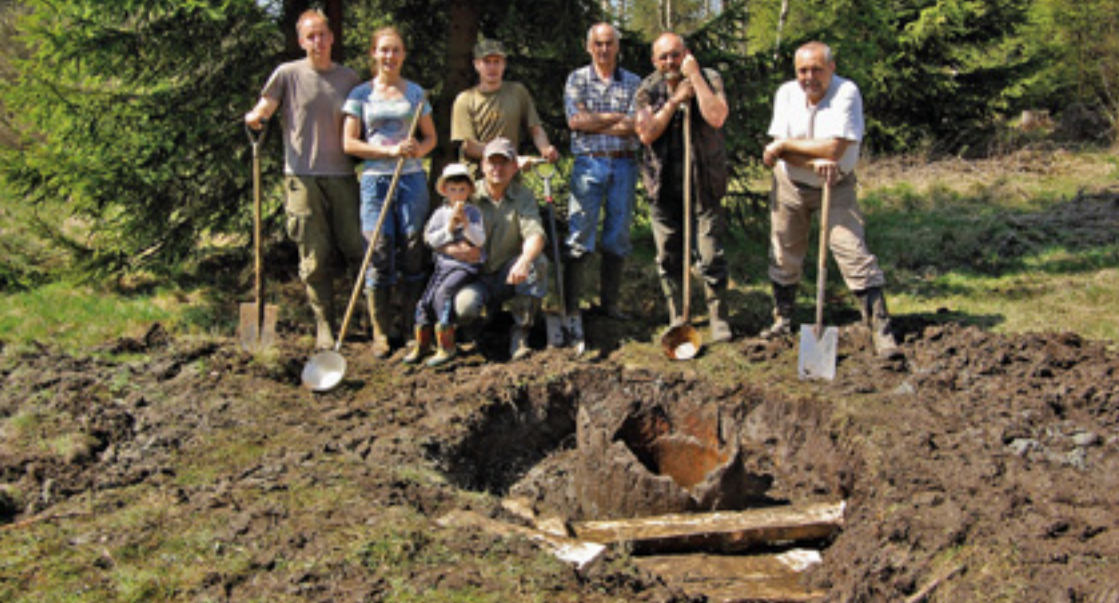
Nad dobře vykonaným dílem – vývěr po dokončení prací. Foto Jaromír Bartoš.
