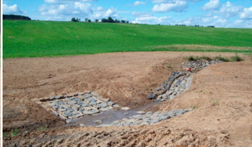
▲ Jedna z neprůtočných tůní u Otročina. Zpevněný brod a balvanitý skluz Otročinského potoka. Obě fotografie Karel Vrána.
