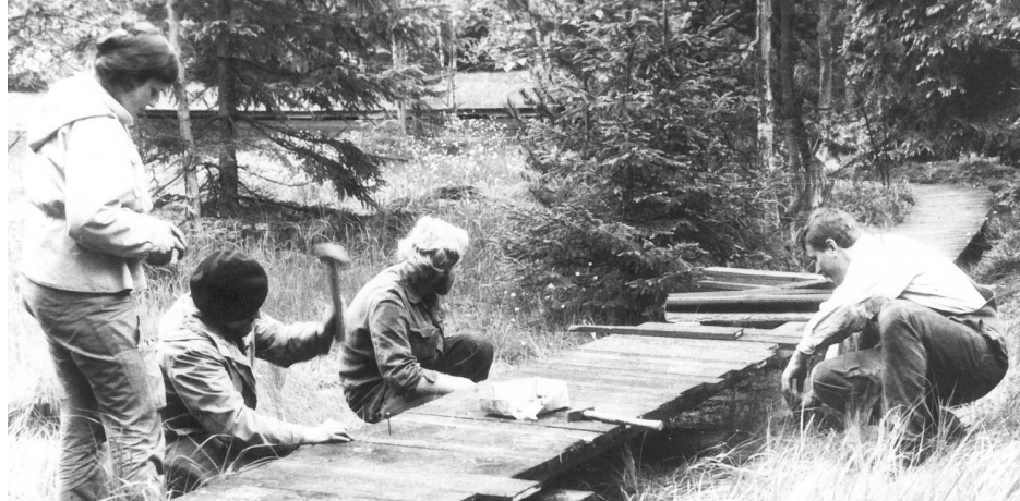
Budování naučné stezky na Kladské, rok 1977. Archiv Správy CHKO Slavkovský les.
